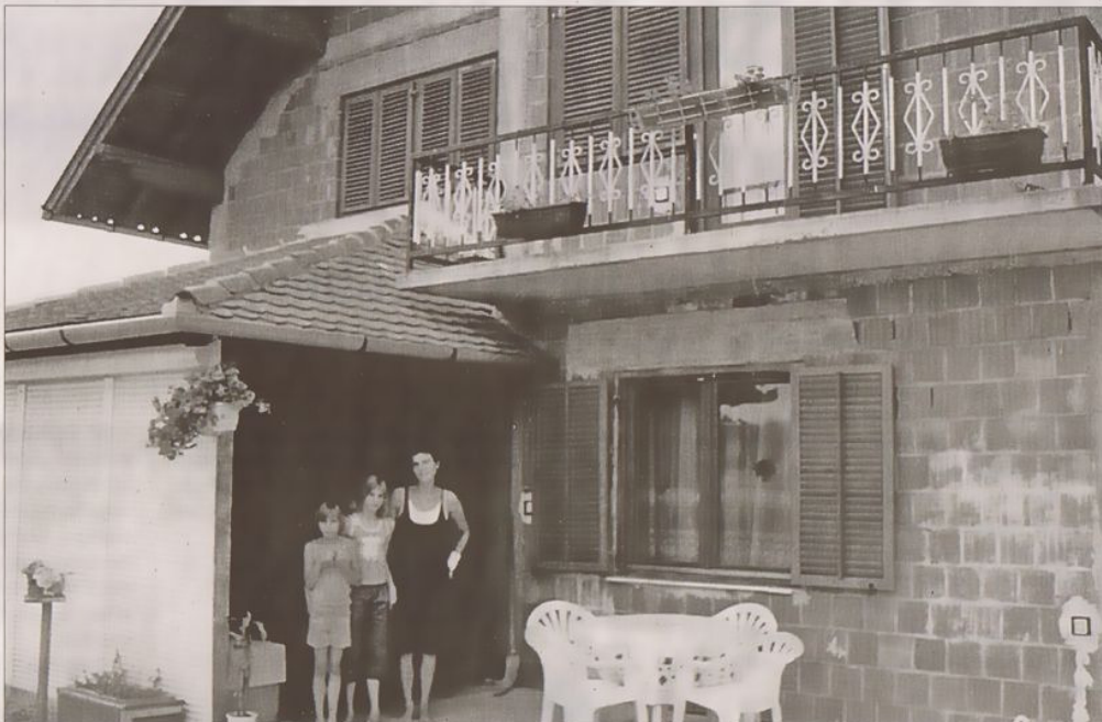
Viel zu tun gibt es für die Helfer aus Mitterskirchen am Haus der Familie Stiblo. Neben Verputz- und Flickarbeiten wird auch der Innenausbau in Angriff genommen. – Fotos: red
